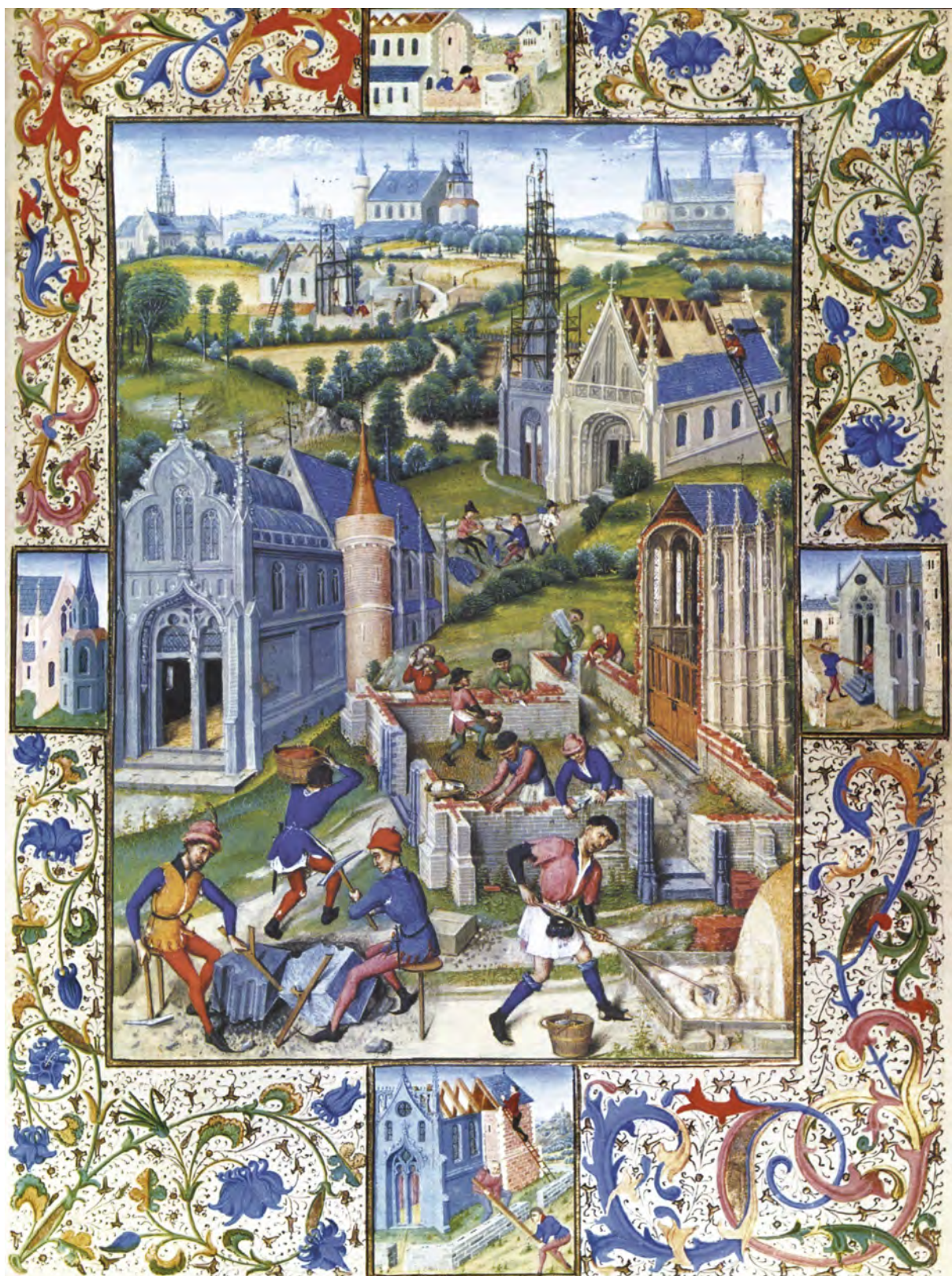
Mercanti che indossano strumenti a rondella - Costruzione di un edificio nel villaggio - Illustrazione medievale originale (fonte: Medieval Panorama, Robert Bartlett, J Paul Getty Museum Pubns 2001)
